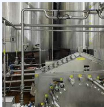
定位清洗流程是厦门和漯河厂房关注的重点。厦门厂房在糖浆定位清洗系统中安装电导装置及自动排放阀，通过优化清洗流程，为每个清洗周期节约1公吨水。漯河厂房在废水处理过程中积极回收水资源，每年可节约4,000至5,000公吨淡水。
