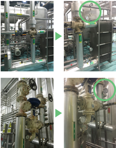
漯河厂在PET线混比板换冰水进出水管及溶糖UHT冰水进出水管加装温度表和压缩空气流量计
